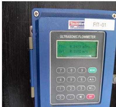
Medidor de vazão da adutora do Boqueirão (1300 L/s) e da válvula dispersora (240 L/s)
