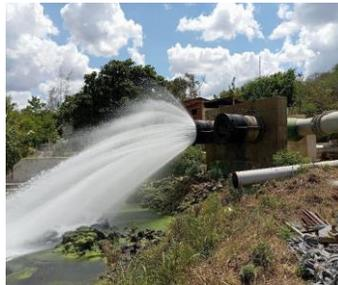
Visita a válvula dispersora do açude de Boqueirão (PB) com vazão de saída de 240 L/s
