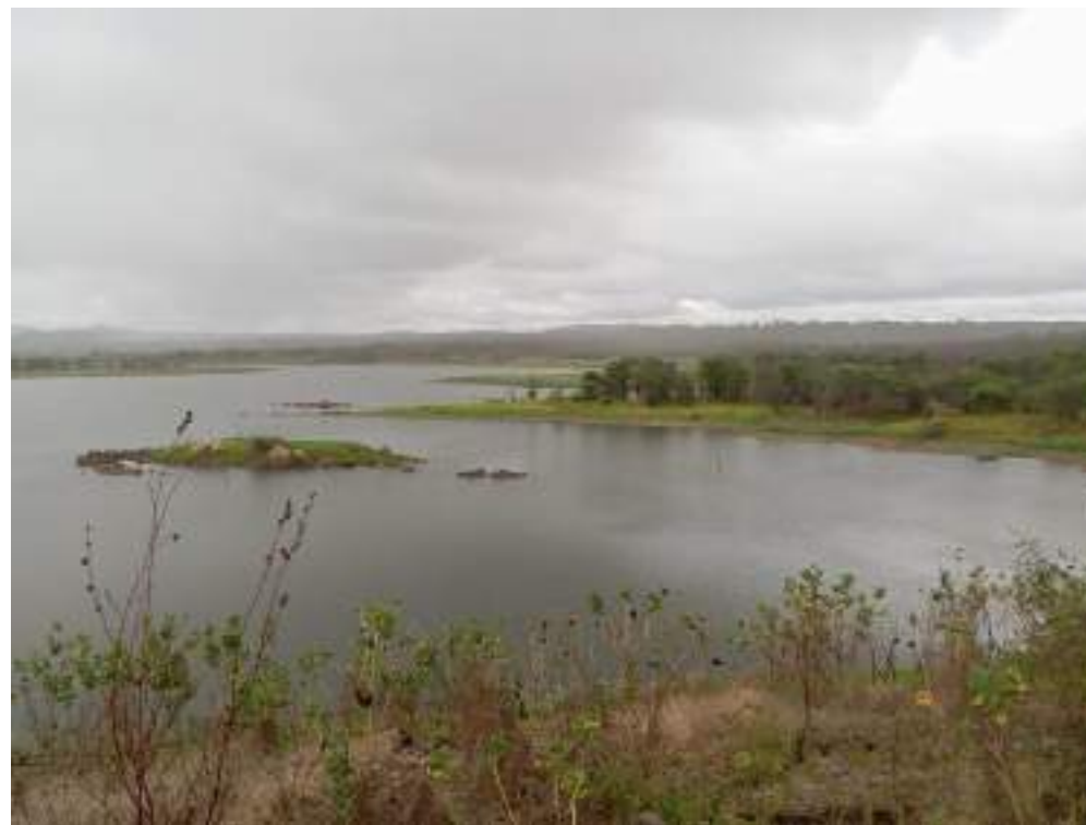
Vista de montante do açude de Serra Branca II e a vegetação no talude e no interior do açude
