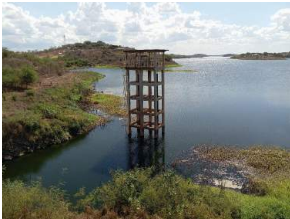
Visita ao açude de Boqueirao e a sua torre de captação de água para a adutora do mesmo nome (Boqueirão – PB)
